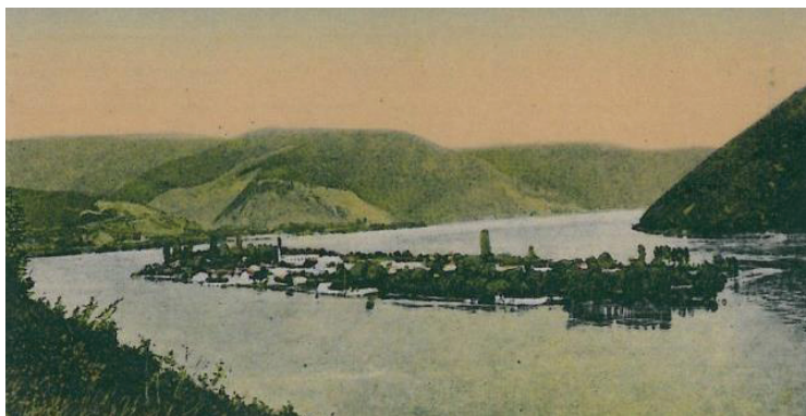
Insula scufundată Ada Kaleh
