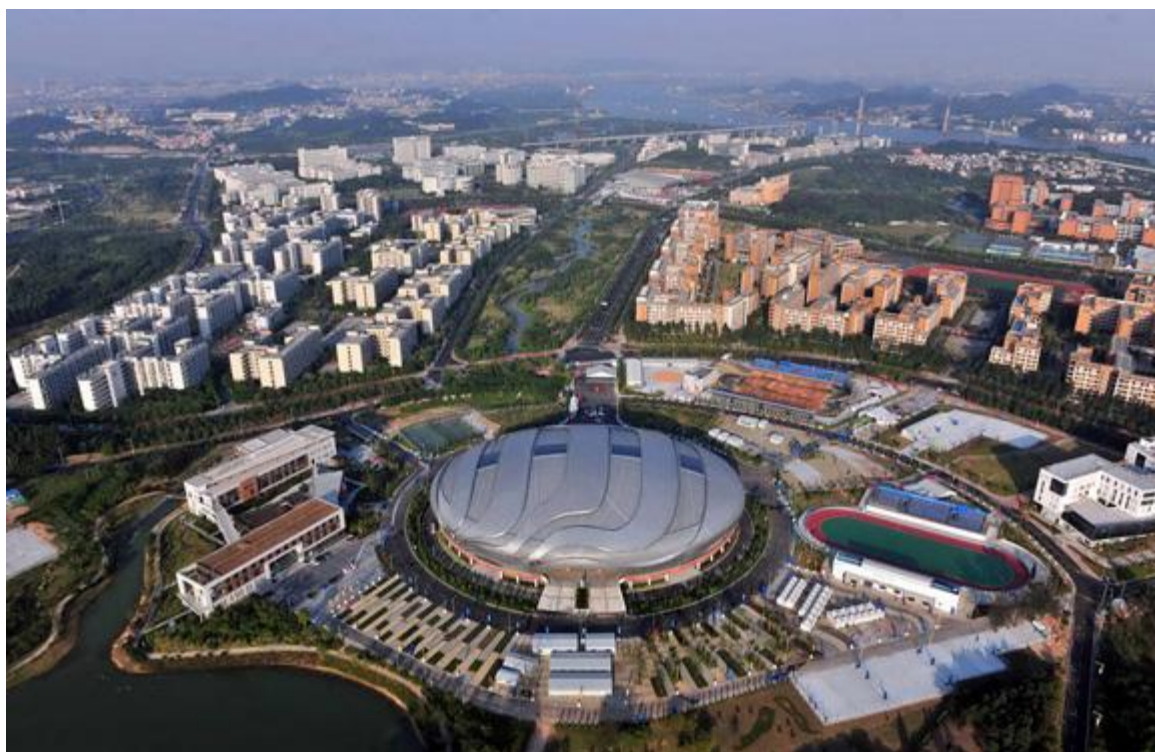
Vedere aeriană a unei părți din „Orașul universitar” din Guangzhou
