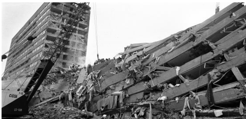
Fig 26. Escombros por remover después del Terremoto en Chile
