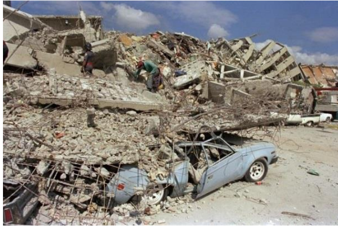
Fig 5. Edificios colapsados después del sismo de México en 1985
