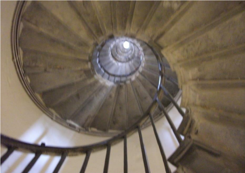
Scara „melc” a Monumentului.
