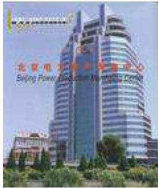
北京电力生产调度中心
