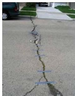
Cum să repară crăpăturile din asfalt
