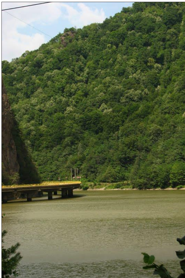
Apeductul Cârlișul Mare, pe Olt.
