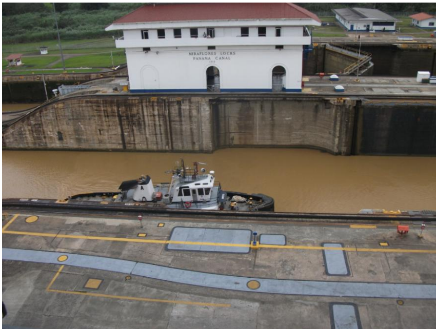
Ecluză Miraflores a Canalului Panama
